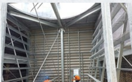
▶ Construcción estructura metálica oriente ecuatoriano.
