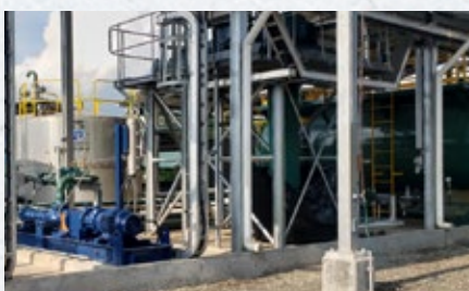
▶ Repotenciación campamento extracción de petróleo.
