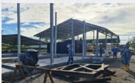
▶ Ampliación campamento perforación de petróleo.
